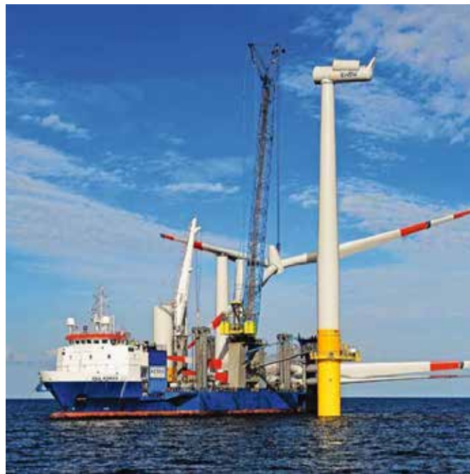
Rys. 4. Montaż skrzydeł wiatraka na farmie EnBW Baltic 1 [11]
