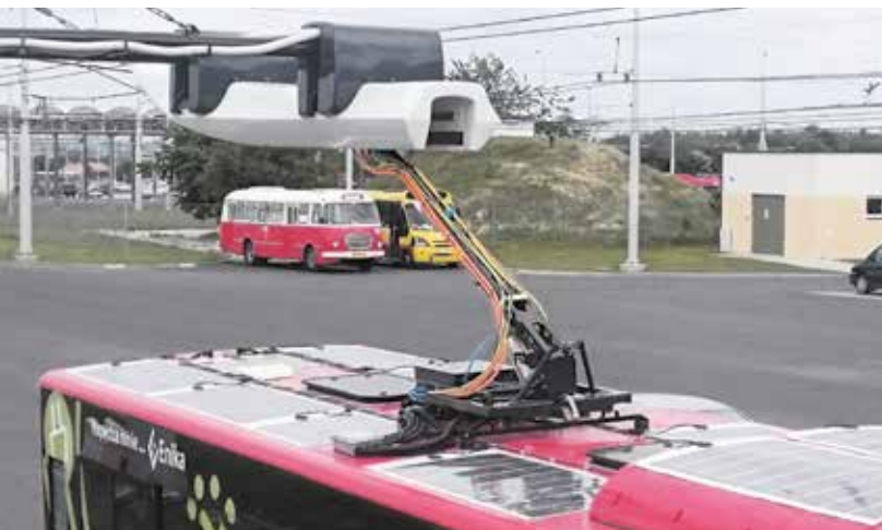
Stanowisko ładowania z pantografu o prądzie maksymalnym 1 000 A
